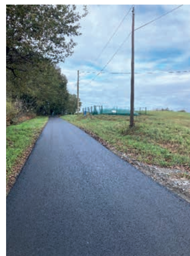
Réfection de chaussée Oihan Ttiki
