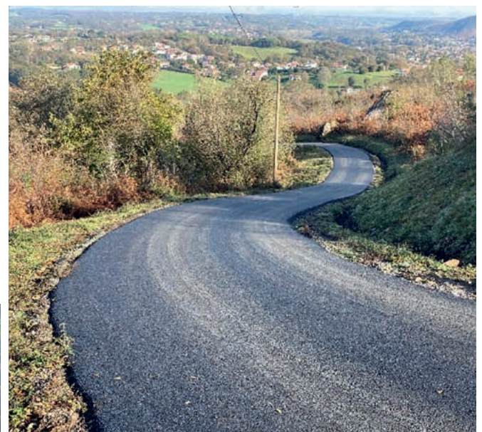
Réfection de chaussée Etxeberriko Borda
