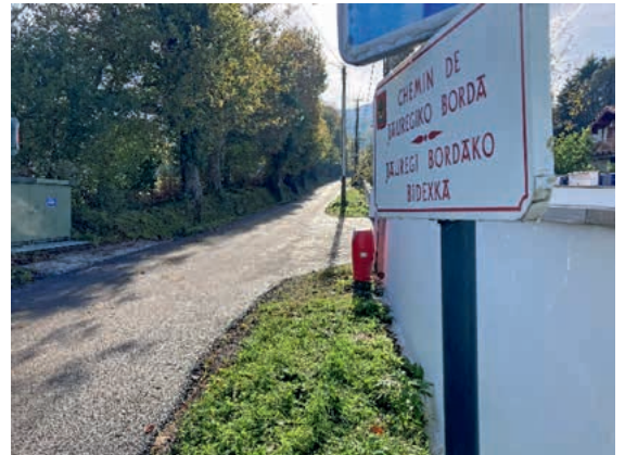
Réfection de la chaussée de Jauregiko borda
